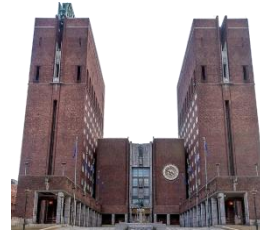
1950: Oslos rådhus, med Nationaltheatret og noen hus i Vika blir første bygg med fjernvarme i Norge
